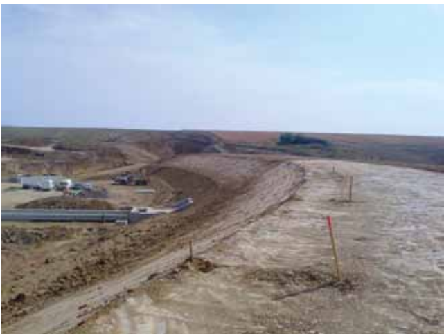
Stanje radova na brani u rujnu 2011.
