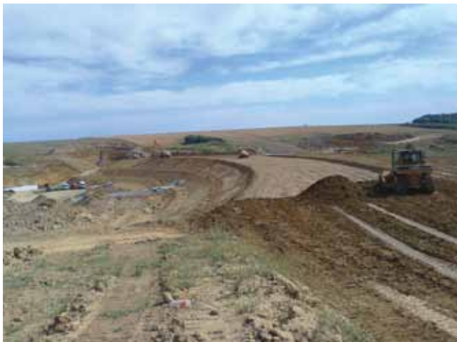
Gradnja zemljane brane Koritnjak
